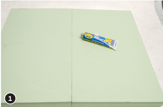
Coller l'une à l'autre (côté longueur) les deux plaques de mousse de polystyrène extrudé.
